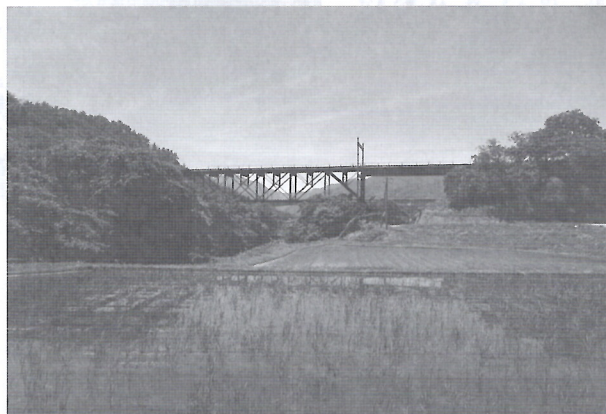
現在の立場川鉄橋 令和6年
